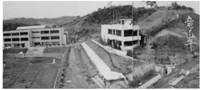
図 14 1号館と図書館 (1968 年頃)
