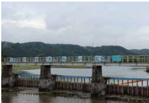
「投渡堰」の風景。写真にある丸太が河川の増水の時には流される。江戸時代から伝わっている技術である。
