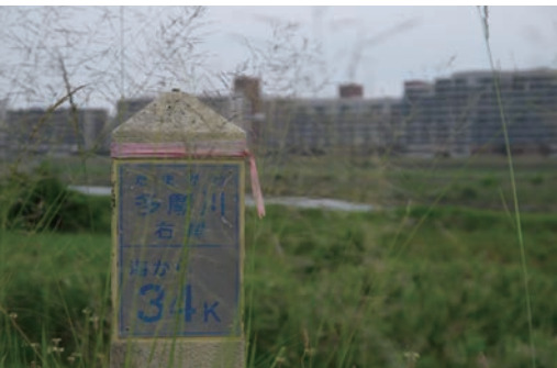
河川距離標。 河口から一定間隔で設置されている。
