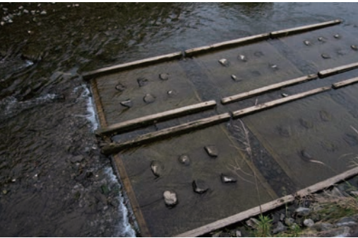
護床工。川の婉曲部分などに置き、川床が削れるのを防ぐ。普通は婉曲部全体に置く
